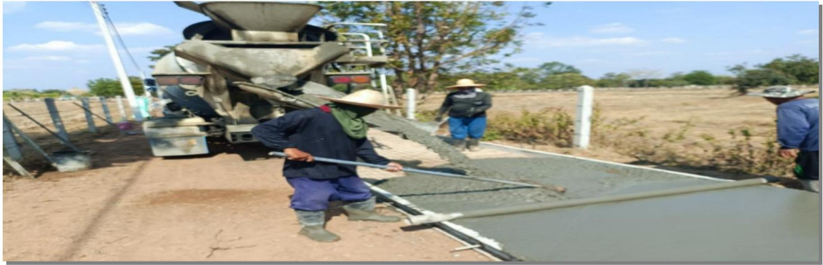
โครงการก่อสร้างถนนคอนกรีตเสริมเหล็กสายคุ้มหัวสะพานไปชลประทาน บ้านดอนยาวหมู่ที่ ๔
